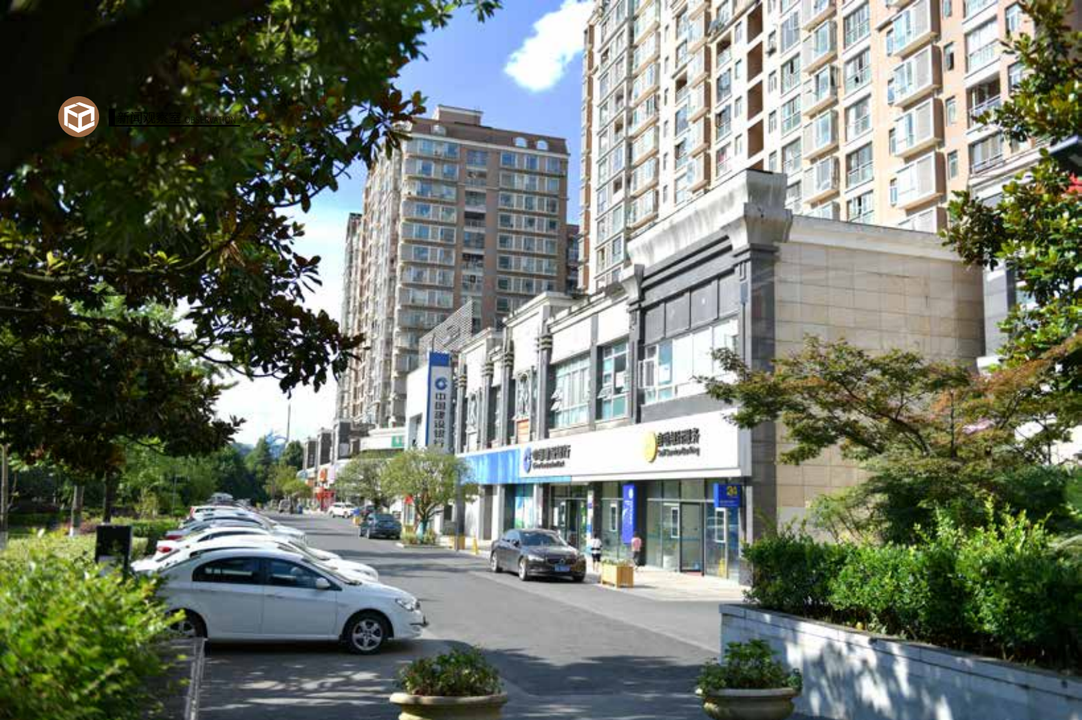
◎沿街商铺门前改造实景
