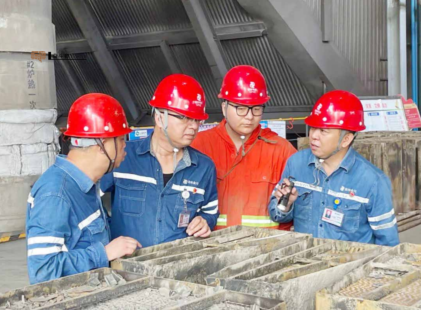
© 宋福昌（右一）在空预器改造现场对施工安全进行检查
