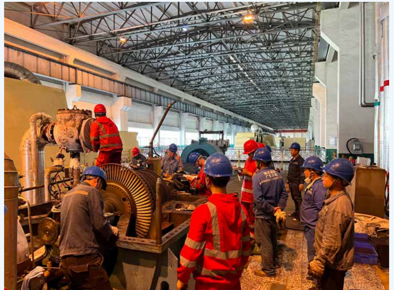
◎ 黔北电厂4号机组C修现场
