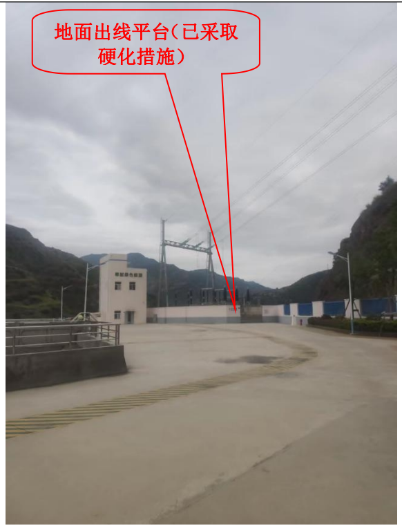
地面出线平台采取硬化措施的现状照片
