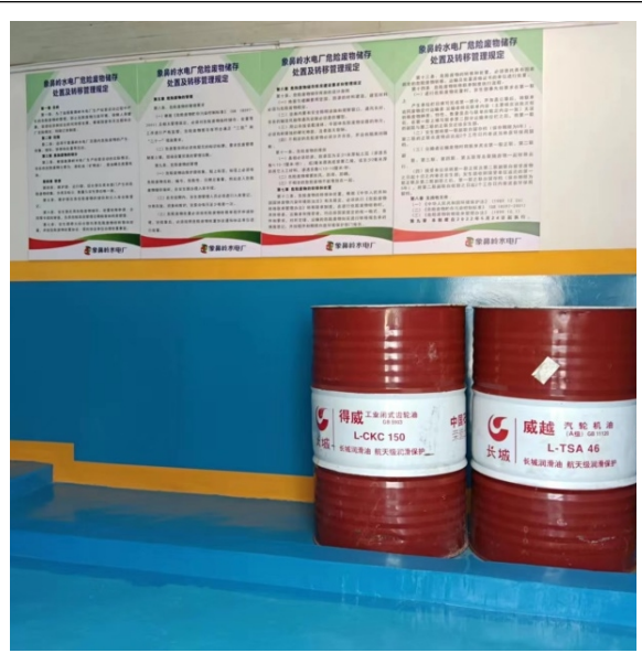
依托象鼻岭一期水光互补农业光伏电站危废暂存间内部的现状照片 1
