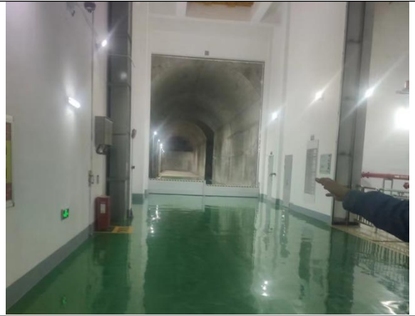
地下主变洞采取硬化支护措施现状照片
