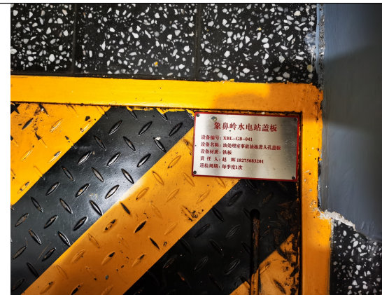
透平油事故应急池现状照片
