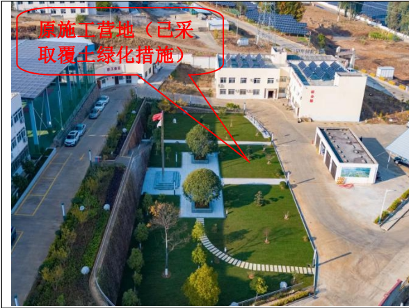
临时工程恢复水保措施现状照片
