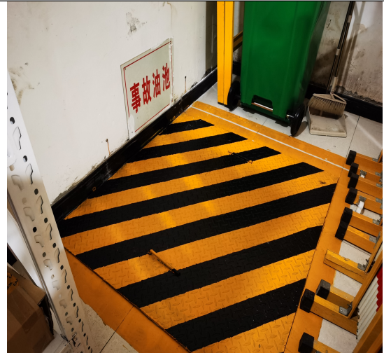
事故油池现状照片
