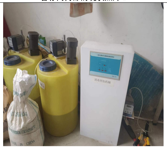
依托象鼻岭一期水光互补农业光伏电站生活污水处理设备及加药设备现状照片
