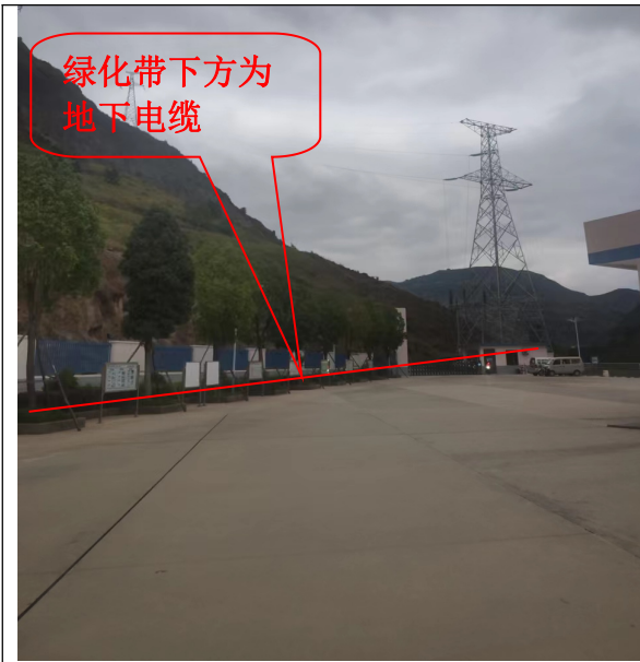
地下电缆上方绿化恢复情况现状照片
