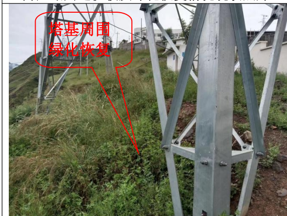
送出线塔基周围绿化恢复情况现状照片 2
