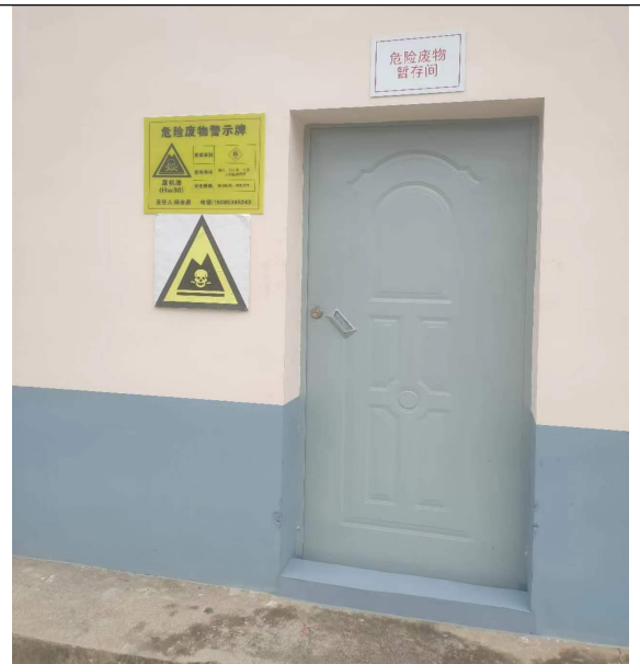
依托象鼻岭一期水光互补农业光伏电站危废暂存间的现状照片
