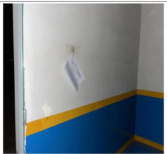
依托象鼻岭一期水光互补农业光伏电站危废暂存间内部的现状照片 2
