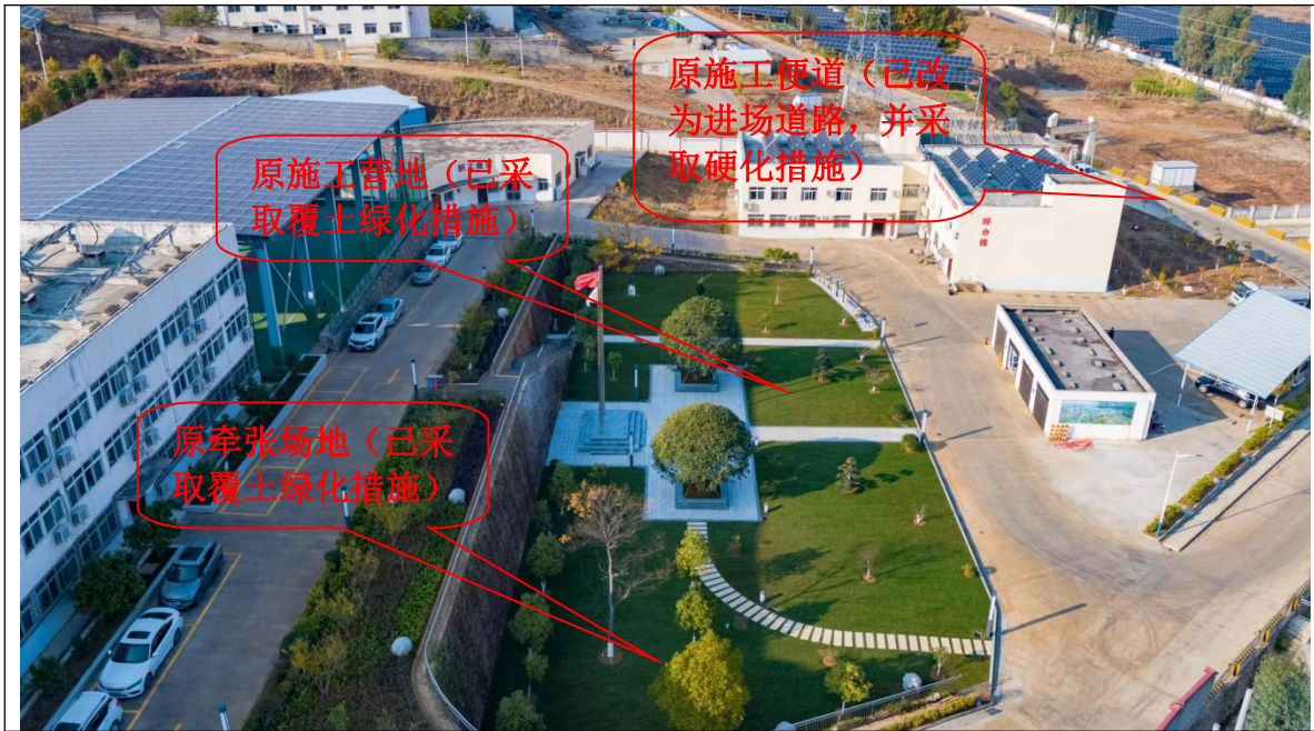
临时工程恢复水保措施现状照片
