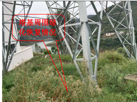
送出线塔基周围绿化恢复情况现状照片 1
