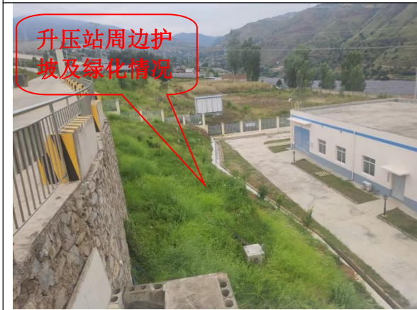
升压站周边护坡及绿化恢复情况现状照片
