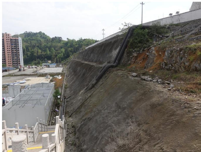
厂区东侧喷砂护坡
