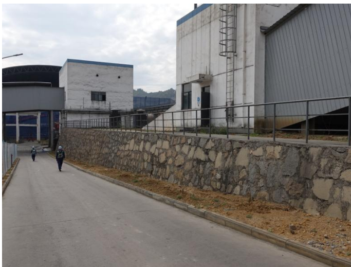
厂区煤库南侧浆砌石挡墙
