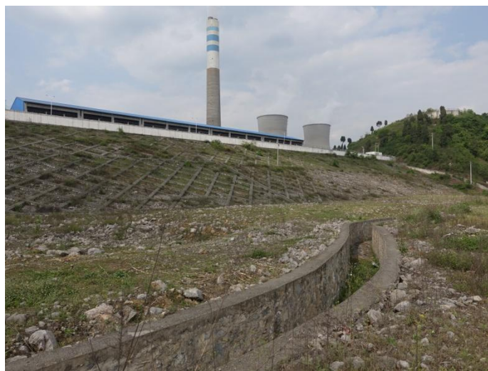
厂区西南侧边坡及排水沟
