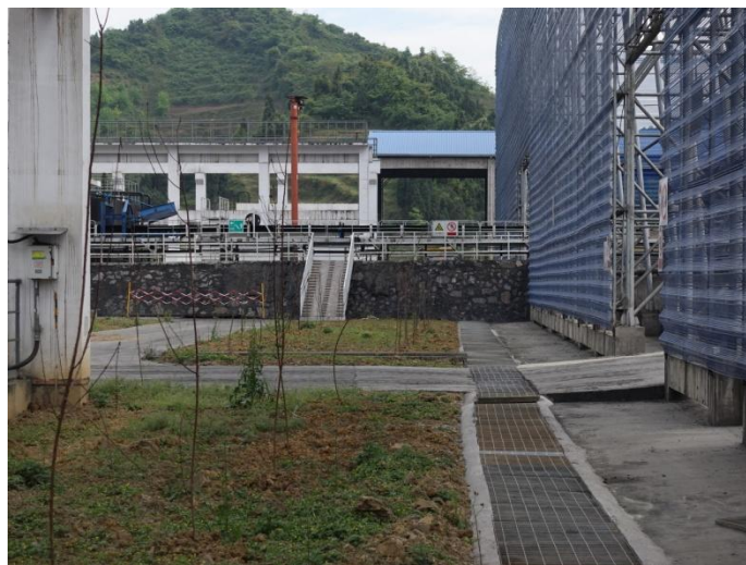
煤场周边挡墙及排水
