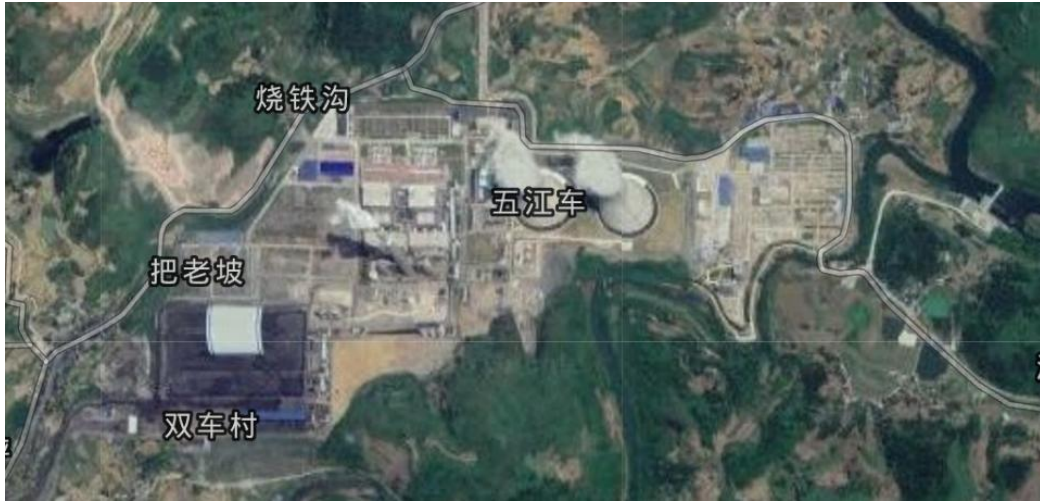
项目区建设完成情况(2016 年)
