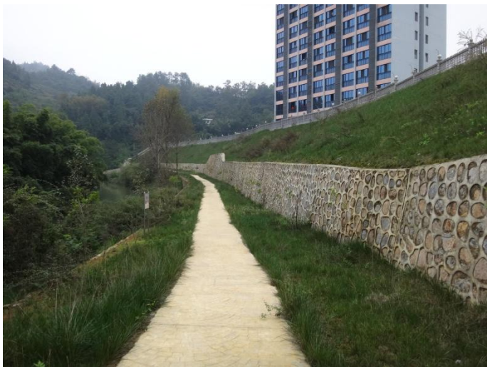
生活区南侧护坡及挡墙
