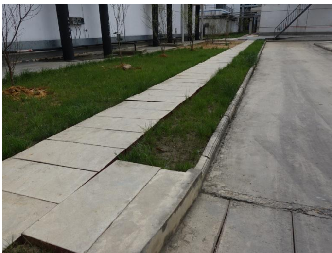
厂区内盖板排水沟
