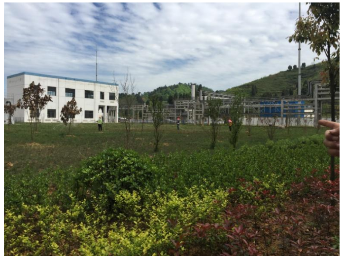
综合水泵房南侧绿化
