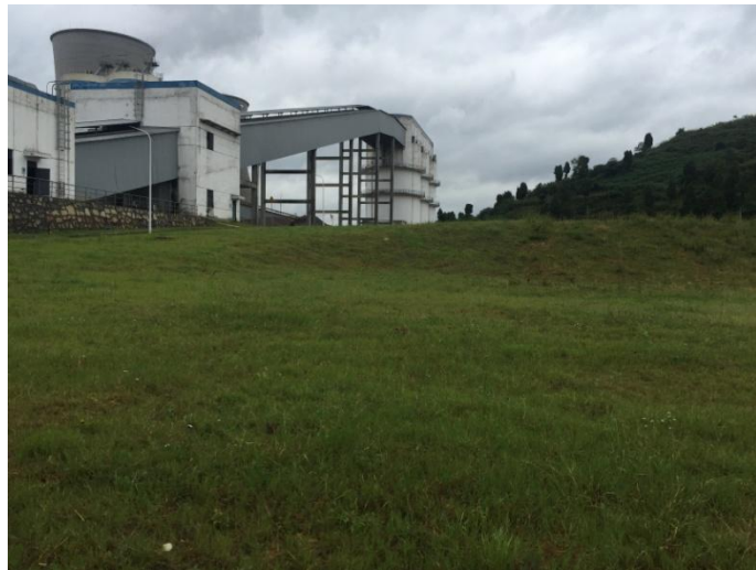
煤场南侧场地平整绿化
