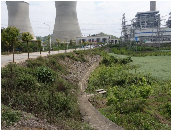
进场道路骨架护坡
