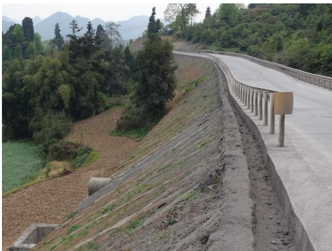
运灰道路骨架护坡及排水
