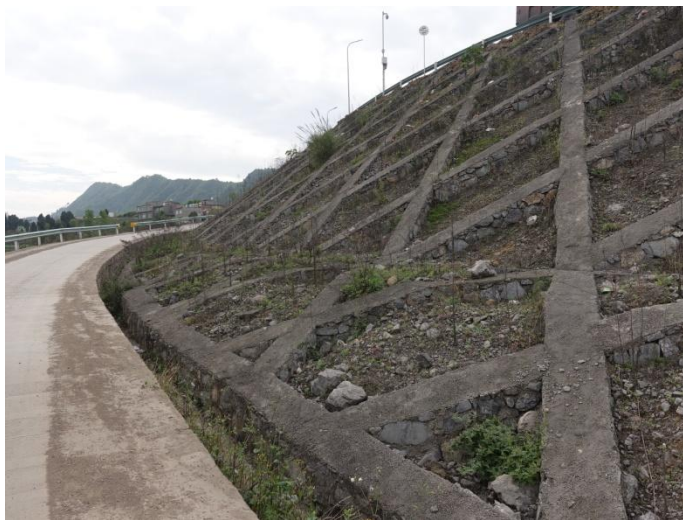
运煤道路骨架护坡及排水沟
