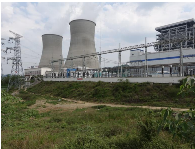
厂区北侧边坡防护
